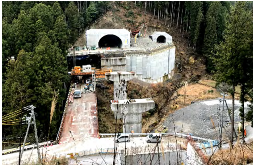
3号トンネル 施工状況
