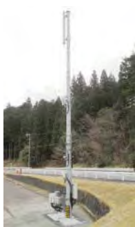
作手診療所にある基地局 (5Gの電波を送受信する電波塔)
