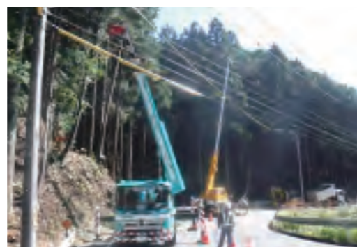
▲主要地方道長篠東栄線で片側交互通行にしての作業状況
