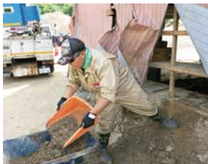
泥かき出し作業
