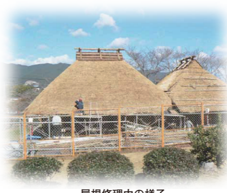
屋根修理中の様子
