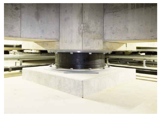
免震装置(積層ゴム)の例
