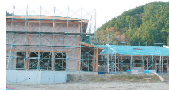
長篠保育園改築工事のようす
