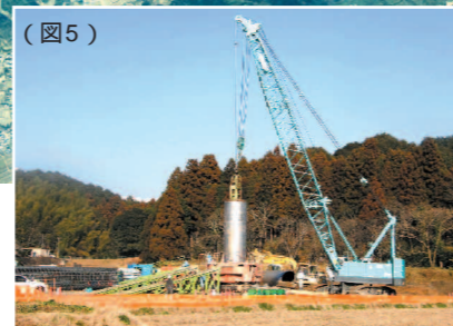
名高田高架橋工事状況(図5)
