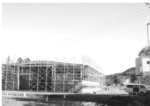
現在建設中の「資源物集積場」のようす
