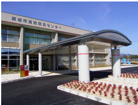
新城市消防防災センター（平井地内）
