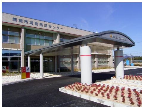
新城市消防防災センター（平井地内）
