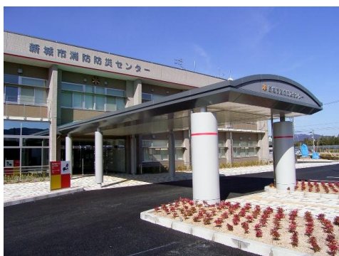
新城市消防防災センター（平井地内）
