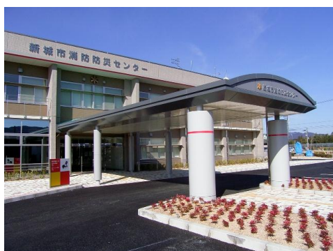
新城市消防防災センター（平井地内）
