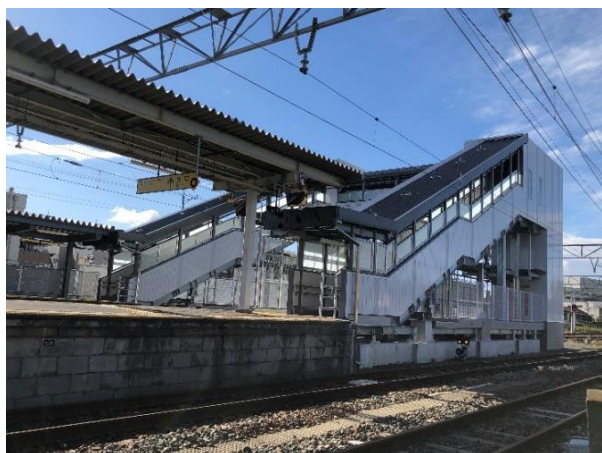
新城駅構内の整備状況
