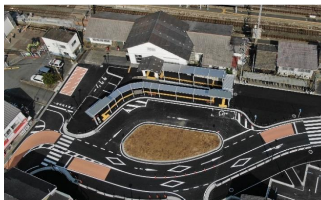
新城駅前広場の暫定整備
