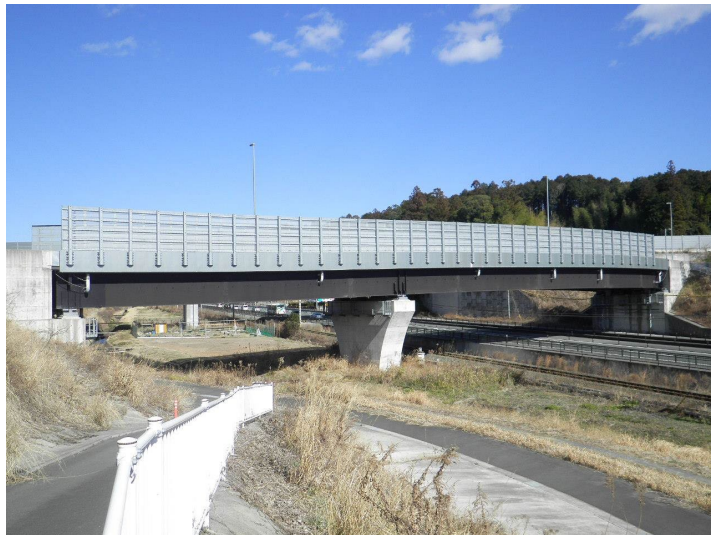
清井田跨線橋（八束穂）
