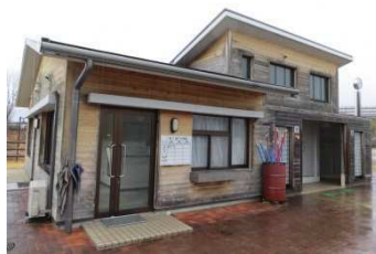
長篠地区多目的広場管理棟
