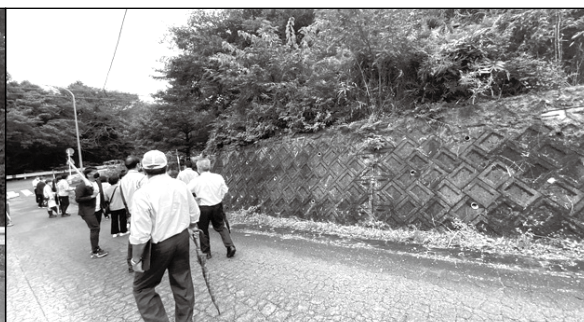
④県用地との高低差(約10メートル)の確認
