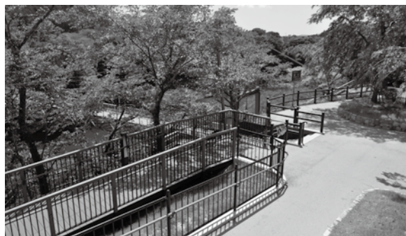
桜淵公園再整備 豊川右岸側整備工事 (デッキスロープ周辺整備状況)
