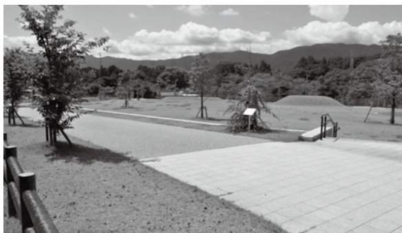
桜淵公園再整備 大芝生広場整備工事 (旧市民プール跡地の整備状況)
