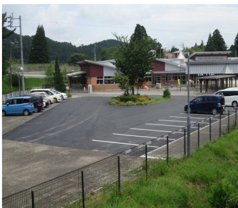
▲駐車場舗装工事完了
