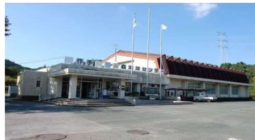
体育館・事務室外観
