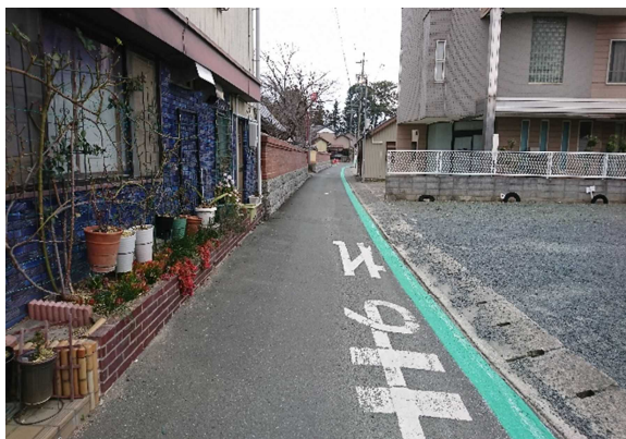
路肩カラー塗装設置
