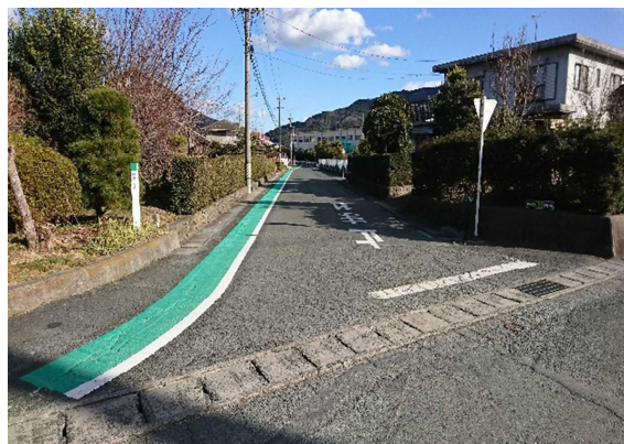
路肩カラー塗装設置
