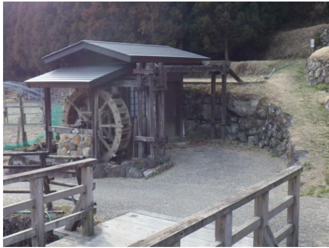
立派に屋根替えされた水車小屋
