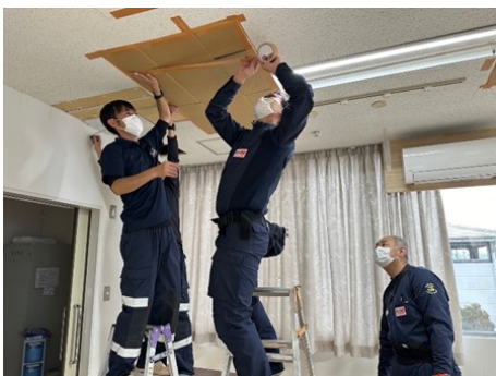
【介護老人保健施設内の復旧作業】
